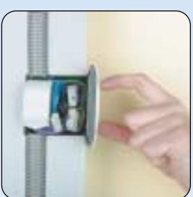
Εγκατάσταση ενεργοποιητή σε κουτί διακόπτη σε συνδυασμό με ασύρματο διακόπτη
