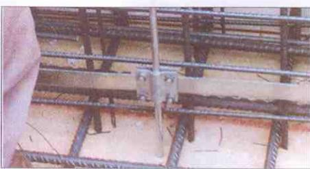
Για τις αναμονές από τη θεμελιακή γείωση στο εσωτερικό του κτιρίου χρησιμοποιείται χαλύβδινος θερμά επιψευδαργυρωμένος (St/tZn) κυκλικός αγωγός Φ8 ή Φ10mm. Για τη σύνδεση του αγωγού με την ταινία χρησιμοποιείται επίσης κατάλληλος σφιγκτήρας αγωγού - ταινίας.
